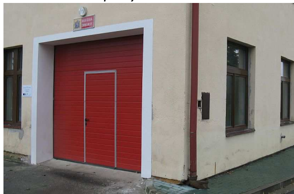
Obr. č. 12: Stav po výměně
