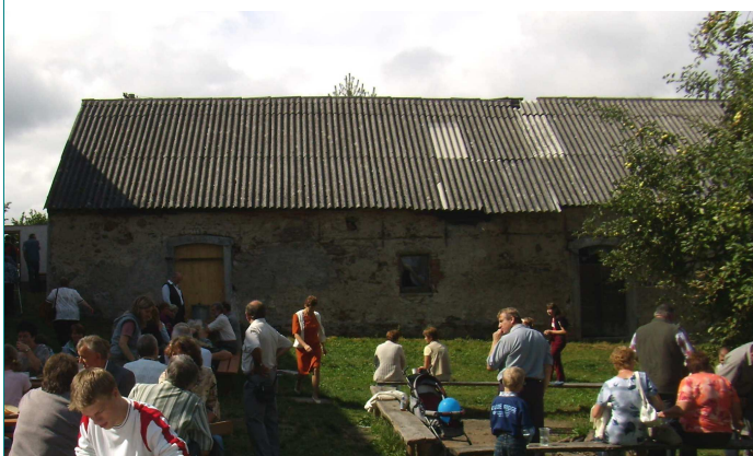
Obr. č. 6: Pohled na hospodářskou budovu před rekonstrukcí
