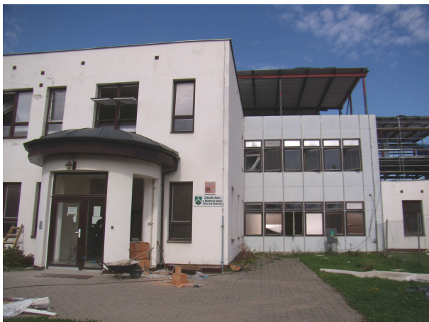
Obr. č. 4: Pohled na budovu MŠ před rekonstrukcí
