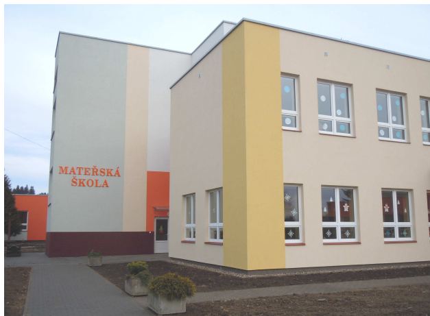
Obr. č. 5: Budova MŠ po nástavbě
