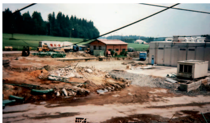
Stavba nové pily
