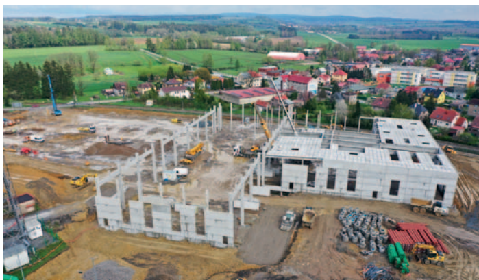
Stavba CLT výrobní haly
