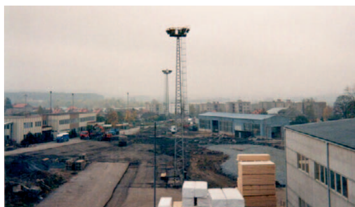
Stavba nové pily
