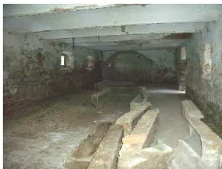
Stav uvnitř budovy před obnovou
